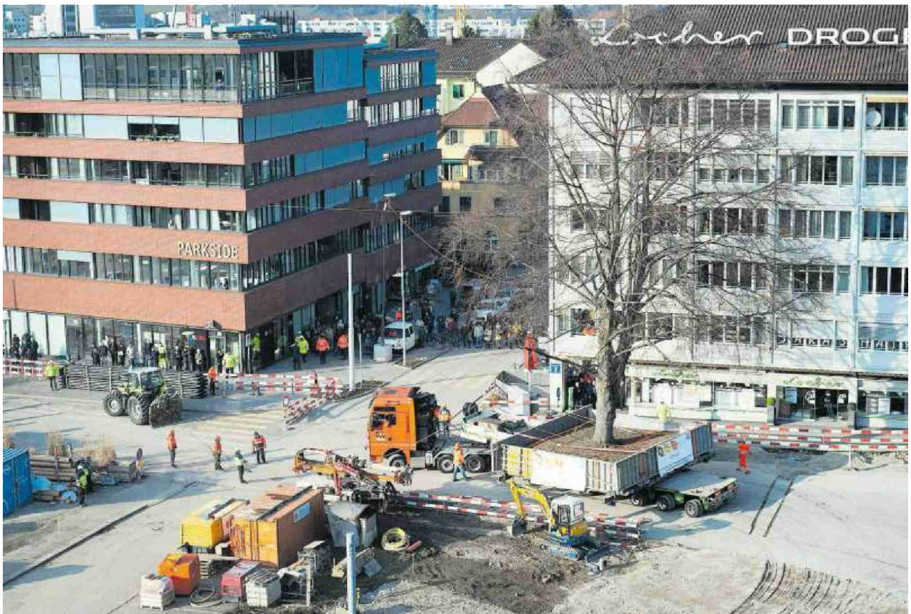
Fast hundert Tonnen setzen sich in Bewegung, der Transport ist ein Novum für alle Beteiligten.
