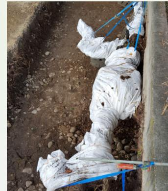
Lors de travaux autour d'un tilleul âgé, l'excavation s'est faite manuellement, les racines dégagées avec précaution et protégées du dessèchement et du rayonnement solaire. La fosse a ensuite été rebouchée aussi rapidement que possible à l'aide d'un substrat adéquat.
